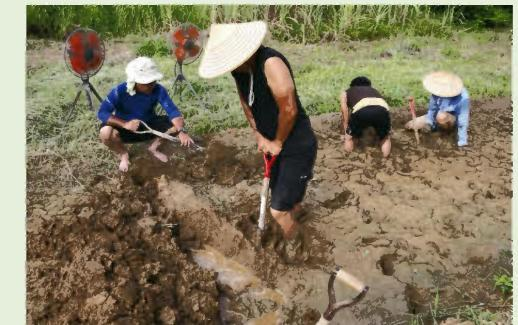
国の重要文化財「旧與那國家住宅」の修復工事に使用される瓦ぶきに使用する土作り。工事の範囲が広がったことから隣り合わせの位置に池を増設。さらに新設した粘土池も熟成してきたので、土壁を崩してひとつの粘土池として混合しました。
